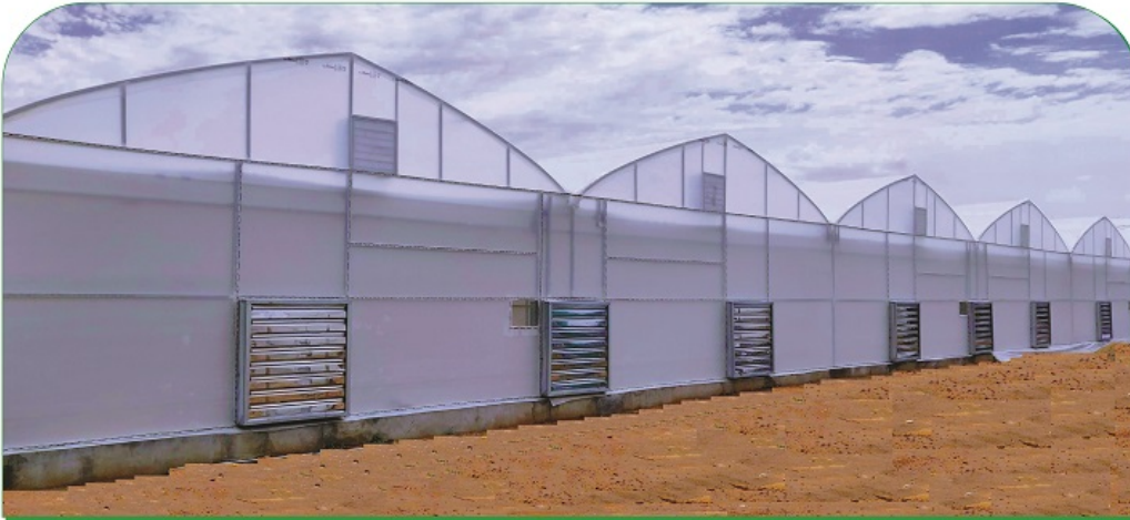
Fan & Pad Greenhouse
